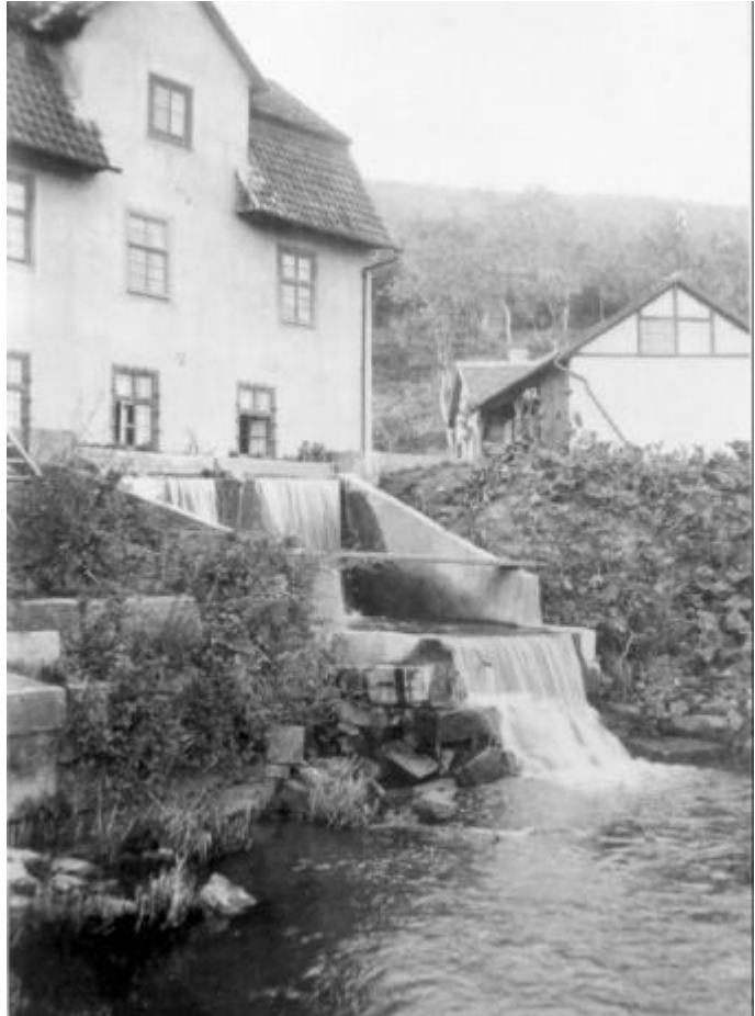
Wasserfall an der Turbine
